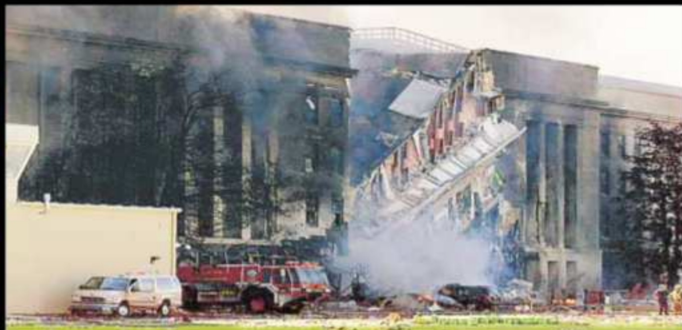
Das schwer beschädigte Pentagon – eine Seite des fünfeckigen Gebäudes ging nach dem Anschlag in Flammen auf, stürzte ein
