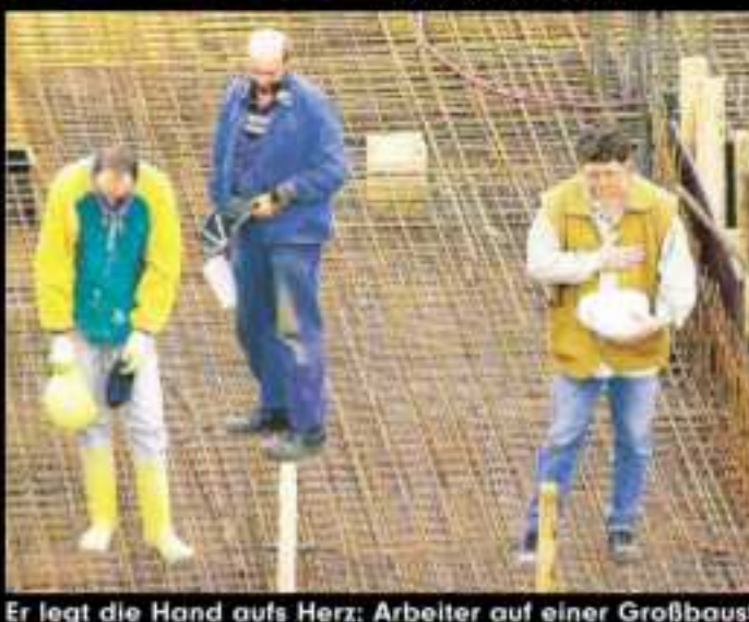
Er legt die Hand aufs Herz: Arbeiter auf einer Großbaustelle in München
